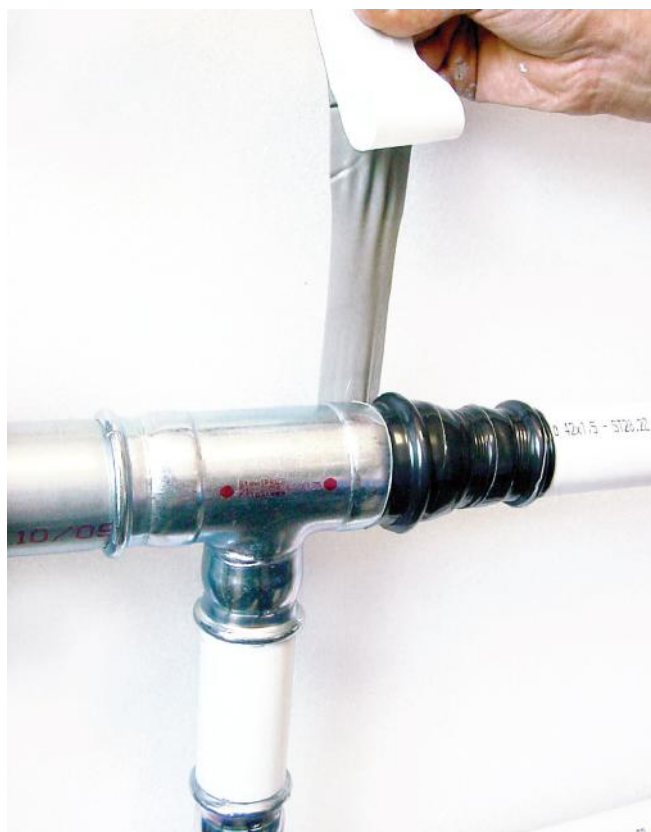
Figura 38 – Protezione dei raccordi con nastro isobutilico
