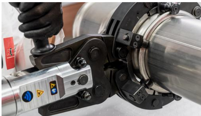
Figura 35 – Assemblaggio pressatura n°2
