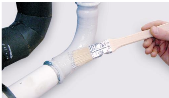
Figura 37 – Verniciatura raccordi e tubazioni con primer
