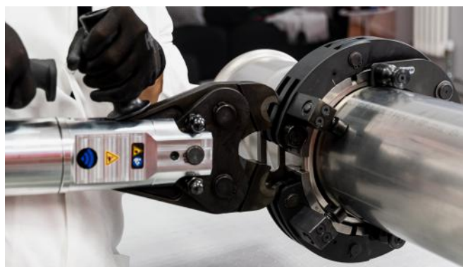
Figura 34 – Assemblaggio pressatura n°1
