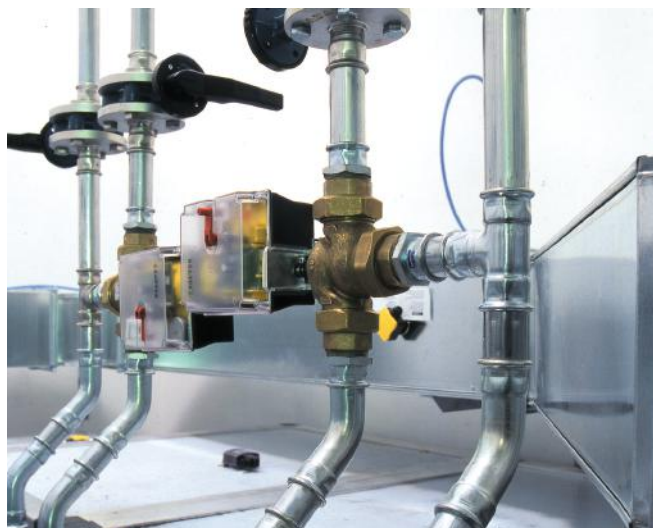
Figura 22 - steelPRES - Acqua di raffreddamento (circuitto chiuso)
